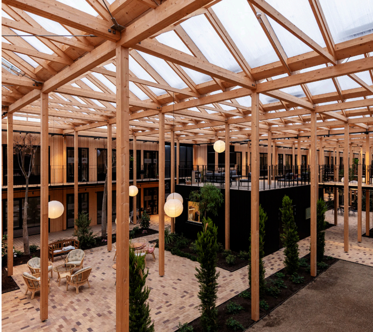
Augusthaven ved Næstved er et moderne boligfællesskab med 60 bæredygtige og fremtidssikrede andelsboliger for voksne uden hjemmeboende børn. De består af 60 2-værelses lejligheder på 53m 2 og har fælles overdækket atriumgård, samt en række fælles faciliteter som gæsteværelser, fælleshus, festlokale, værksted og delebil. Udviklet af Tetris A/S med Sangberg som arkitekttrådgiver. Foto: Agorahaverne. https://agorahaverne.dk
